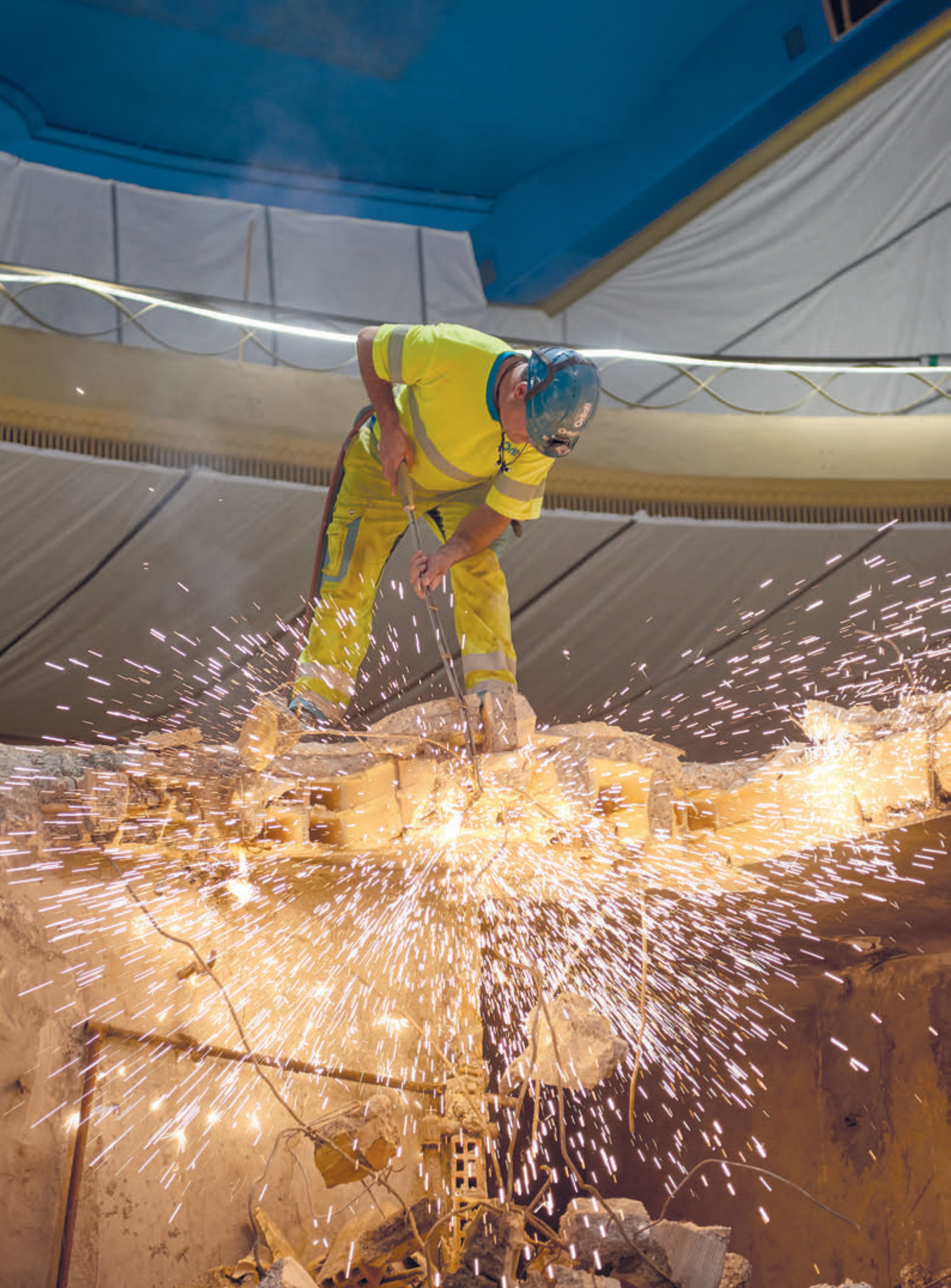
Arbeiter auf der Baustelle des Kinos Capitale beim Ausheben des Parterres unter dem historischen Kinosaal.
